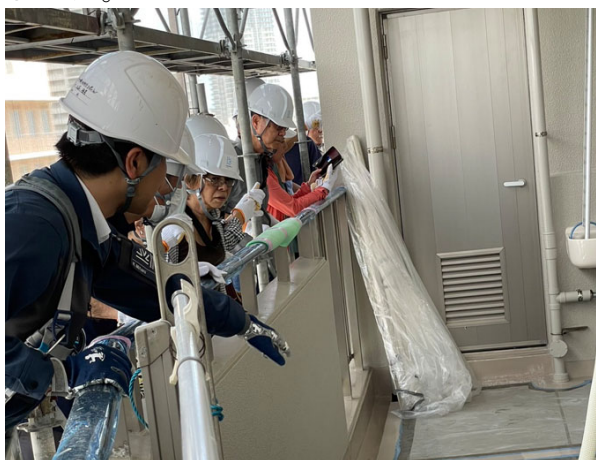
(大規模修繕現場で熱心に説明を聞く参加者)
