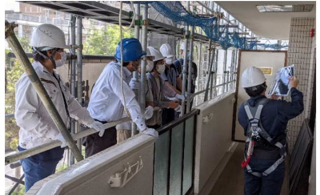
（大規模修繕現場で熱心に説明を聞く参加者）
