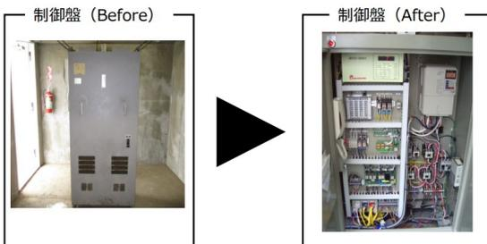
・クイックルリニューアル改修で、従来の制御盤・巻上機・電送系統付随物のすべてを交換するニューアルを制御盤のみを交換することで、工事期間短縮、低コストを実現しました。
